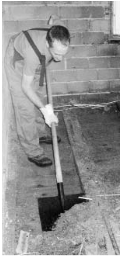
Harte Arbeit. Die Zivilschützer beseitigten auch Schlamm.
