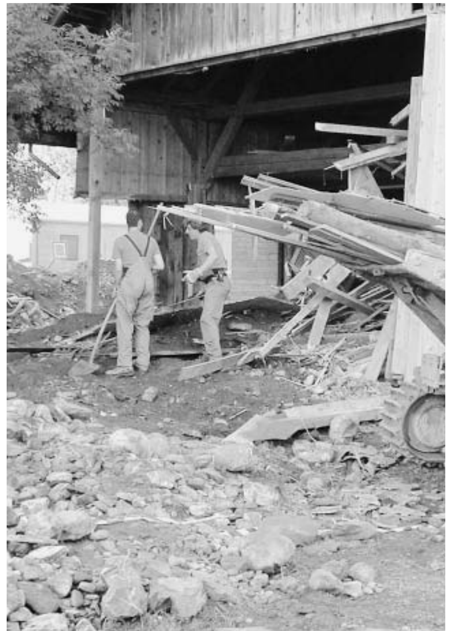
Vom Hochwasser verwüstet. Das Wasser spülte Geröll, Holz und Schlamm in die Ortschaften und setzte Häuser unter Wasser.
